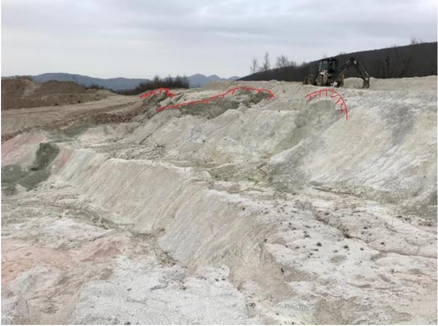
Şekil 16. Açık ocak alanındaki bazı palyelerde meydana gelen duraysızlıkların görünümü
