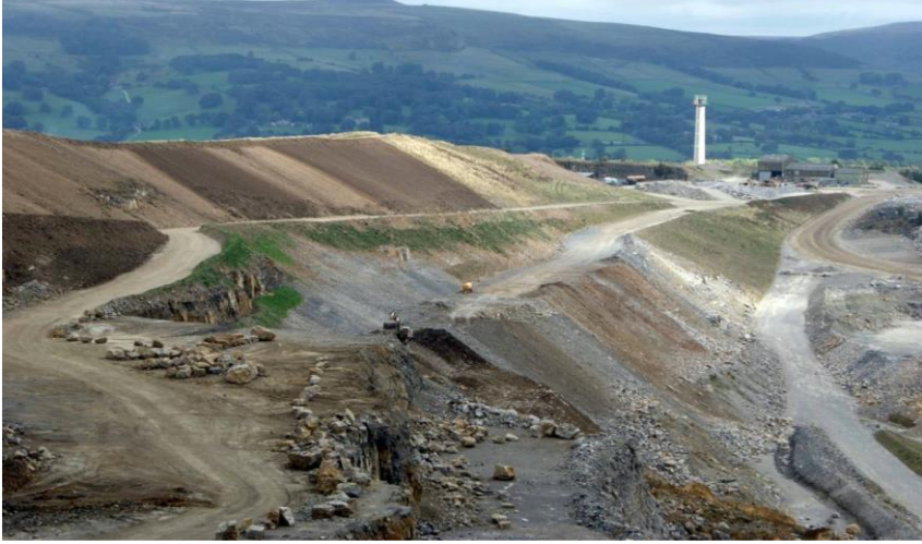
Şekil 7. Basamaklara pasa dökümü ile şev açısını değiştirme
