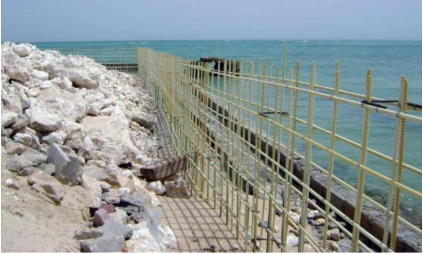
Şekil 2. Korozif Ortamlarda GFRP kullanımı (Fiberglass (GFRP) Composite Rebar,2019)
