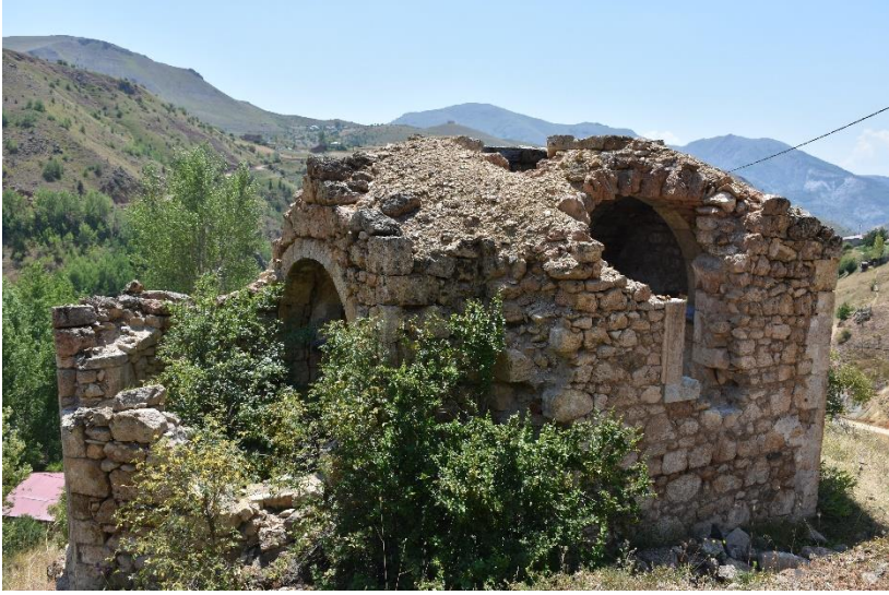
Şekil 10. Şamanlı Şapeli Üst Örtü Sistemi Genel Görünümü
