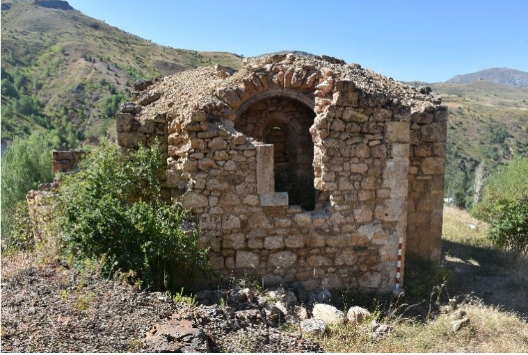
Şekil 7. Şamanlı Şapeli'nin Kuzey Cephesi Genel Görünümü
