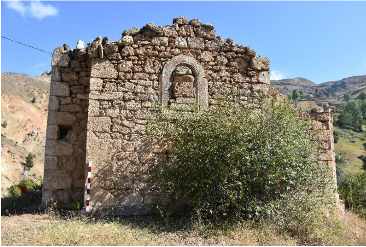
Şekil 8. Şamanlı Şapeli'nin Güney Cephesi Genel Görünümü
