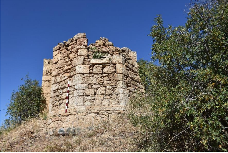
Şekil 9. Şamanlı Şapeli'nin Doğu (Apsis) Cephesi Genel Görünümü
