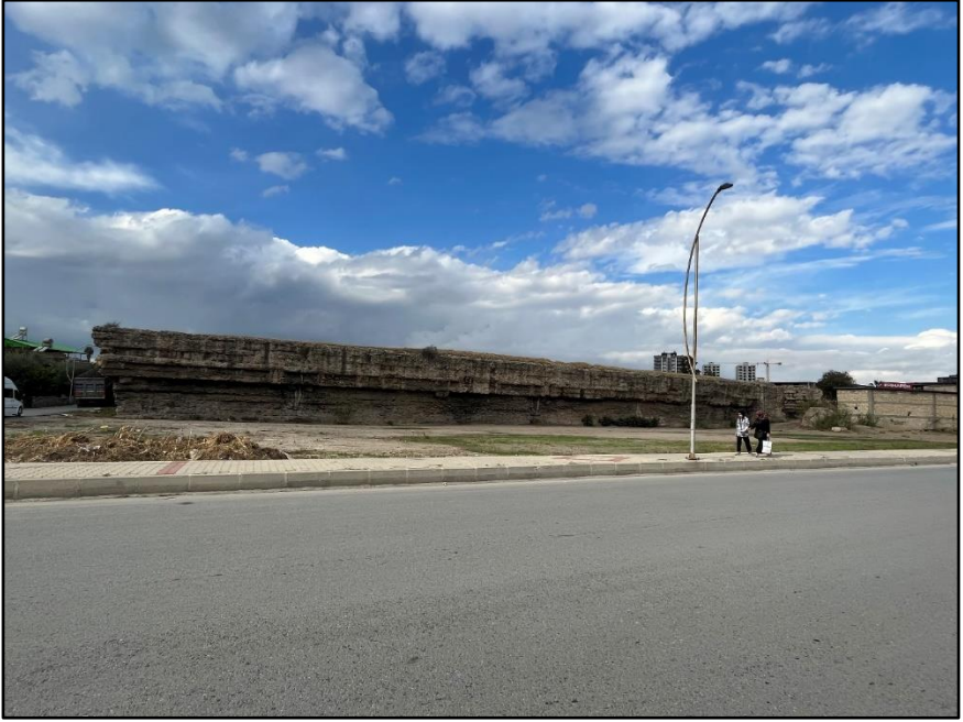
Şekil 4: Donuktaş Tapınağı'nın Doğu Duvarlarından Bir Görünüm.
