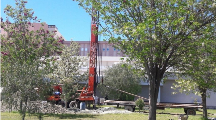
Fotoğraf 23. TASK İçerisinde Su Arama İçin Yapılan Bir Sondaj çalışması
