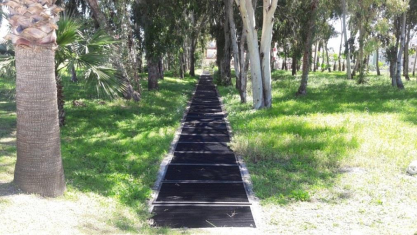
Fotoğraf 25. TASK Üstü Açık Drenaj Ağı
