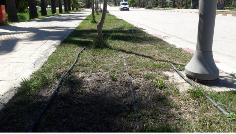
Fotoğraf 3. TASK Yol Kenarı Ağaçlandırma ve Damla Sulama Sistemi
