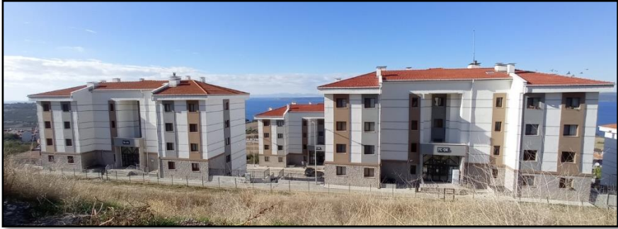
Görsel 11: Erenköy sınırları dahilinde tamamlanan TOKİ konutları
