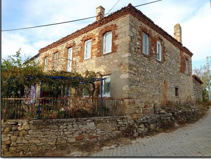
Görsel 4: Taşın ve tuğlanın bir arada kullanıldığı mesken
