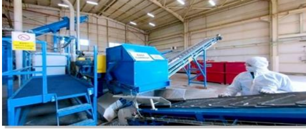
Şekil 4. Arçelik geri dönüşüm tesisleri
