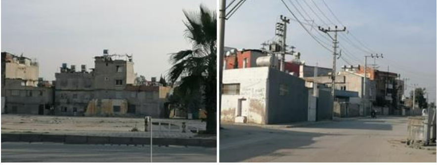
Şekil 7. Çay Mahallesi Atatürk Bulvarı (D400) Üzerinden (sol) ve 146. Caddeden (sağ) Bir Görüntü. Kaynak: Yazar.
