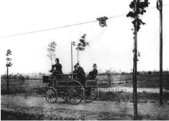
Şekil 1. 1882 yılında Berlin'de Siemens tarafından üretilen "Elektromote".
