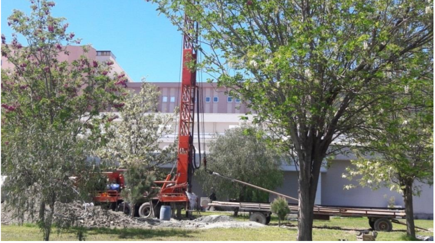
Fotoğraf 23. TASK İçerisinde Su Arama İçin Yapılan Bir Sondaj çalışması
