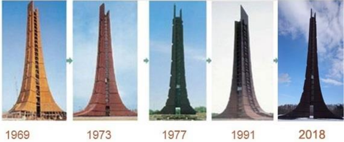
Şekil 8. Corten çeliğin zaman içindeki renk değişimi (Yüzüncü Yıl Anıt Kulesi, Ken Iguchi, Hokkaido Hokkaido, Japonya) (Nippon Steel, 2022)
