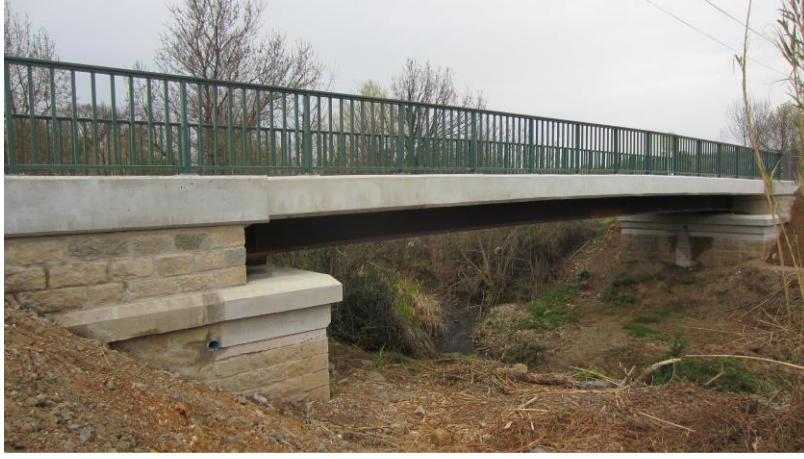
Şekil 6. Birkaç hafta dış mekâna maruz kaldıktan sonra tamamlanmış köprü
