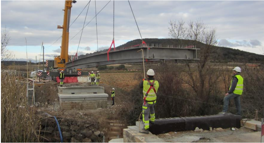
Şekil 5. Çelik yapının oksit tabakası olmadan montajı sırasında kompozit köprü, San Martin à Fontes, Fransa
